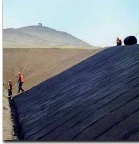
Yüzey erozyon koruması, Peru
