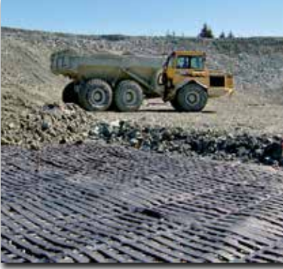
Paralink™ depolama alanının zemin güçlendirmesi Goldex Madeni, Kanada
