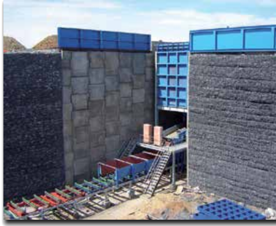
MacRes® ve Terramesh™ uç duvar Optimum Kömür Ocağı, Güney Amerika
