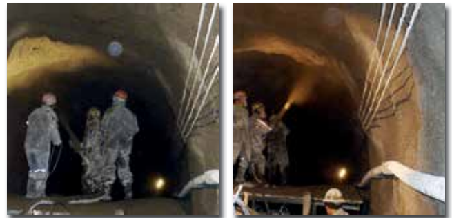
Wirand çelik tel ile güçlendirilmiş püskürtme beton Pillones, Peru
