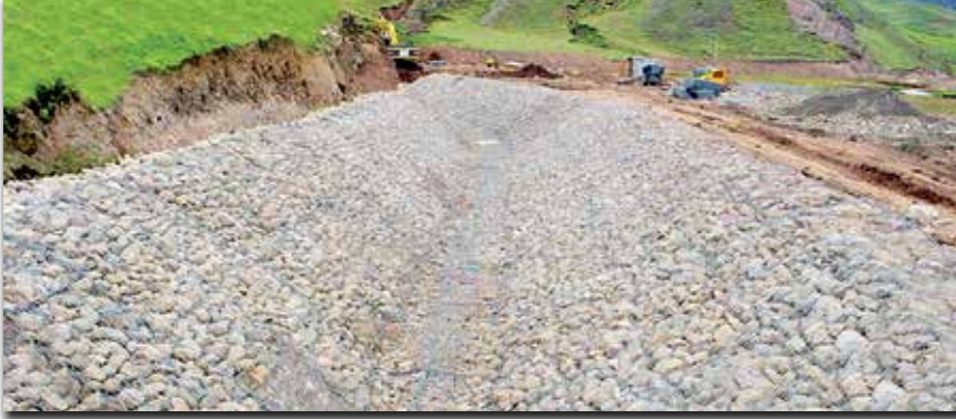
Reno Mattress™ (Şilte Gabion) erozyon kontrolü
