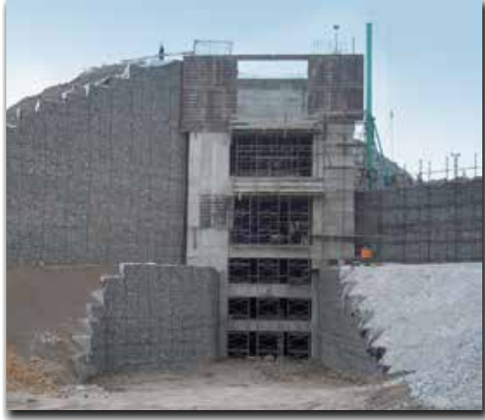
Terramesh™ kuvvetlendirilmiş zemin duvar Iduapriem Madeni, Gana
