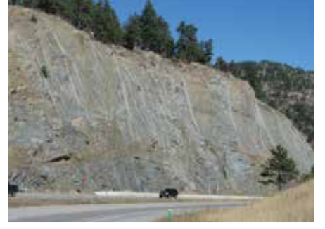
Basit tel ağı sistemleri- Yüzeysel örtüleme
