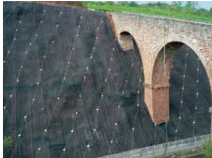
Zemin çivisi ve yüzeysel stabilizasyon uygulamaları
