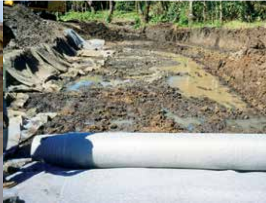
Zayıf zemin stabilizasyonu
