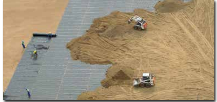
Obruk oluşumlarında temel zeminini güçlendirme
