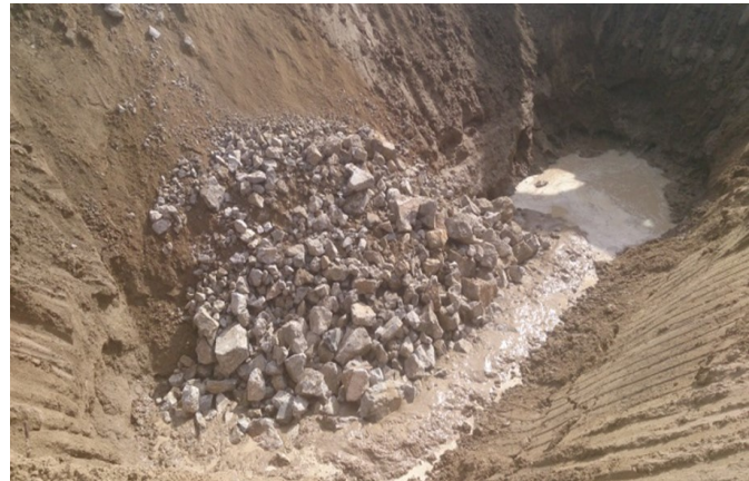
Şilte gabion ve geotekstil uygulama öncesi
