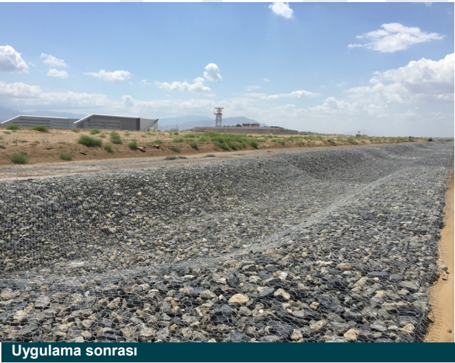
Şilte gabion ve geotekstil uygulama esnası
