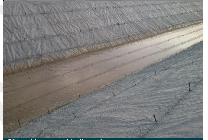
Şilte gabion ve geotekstil uygulama esnası
