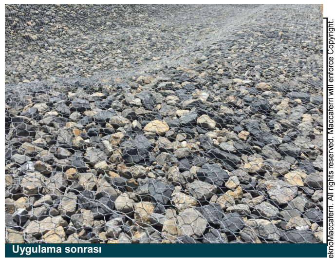
Şilte gabion ve geotekstil uygulama esnası
