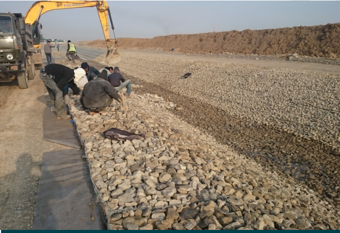
Şilte gabion ve geotekstil uygulama esnası
