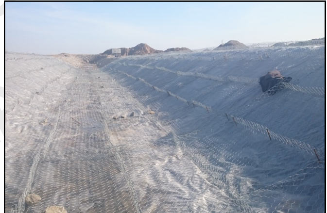
Şilte gabion ve geotekstil uygulama esnası
