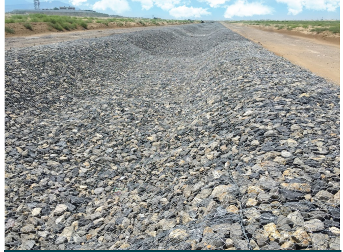
Şilte gabion ve geotekstil uygulama sonunda
