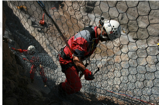
Resim 2. Baraj Gövdesi Üzeri Şev Koruma Uygulaması
