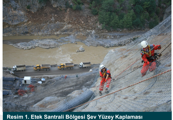
Resim 1. Etek Santrali Bölgesi Şev Yüzey Kaplaması
