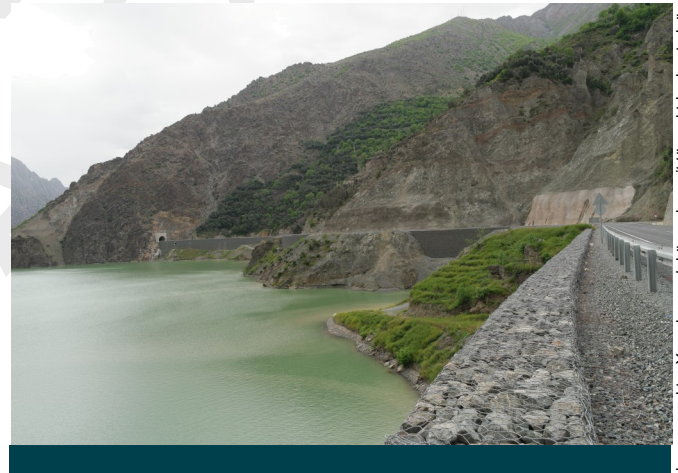
Terramesh Sistem Ünitesi yüzey elemanı ve ikincil donatı elemanı olarak çalışır
