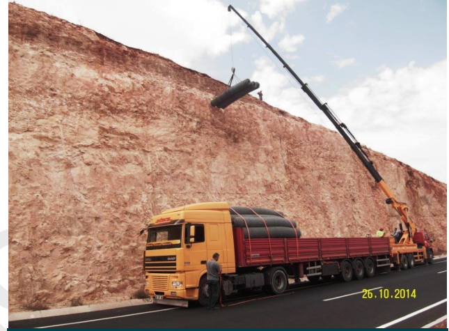
Resim 1. Şanlıurfa Güneybatı Çevre Yolu Çelik Grid Uyg.
