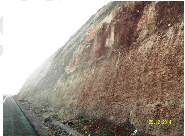
Resim 2. Şanlıurfa Güneybatı Çevre Yolu Çelik Grid Uyg.
