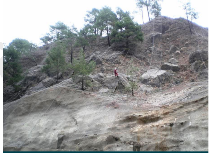
Resim 2. Baraj Gövdesi Üzeri Şev Koruma Uygulaması
