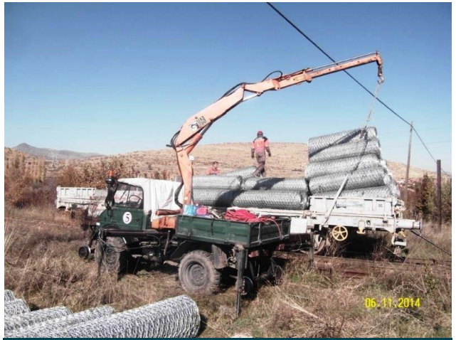
Resim 3. IKZ Demiryolu Şev Koruma Uygulaması
