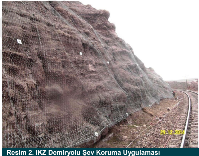
Resim 2. IKZ Demiryolu Şev Koruma Uygulaması
