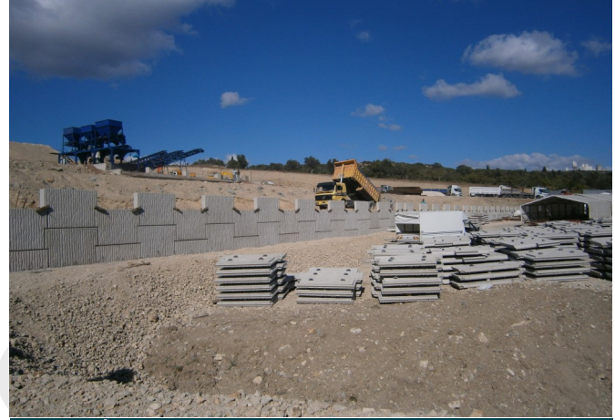
MacRes İstinat Duvarı Yapım aşaması
