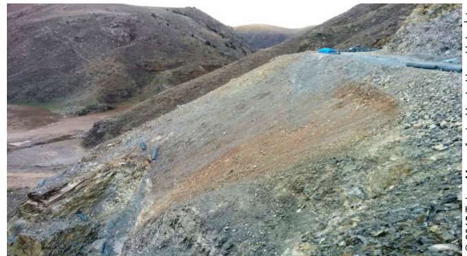
Resim 3. Ardahan Barajı Kazı Şevlerinde Koruma Uygulaması
