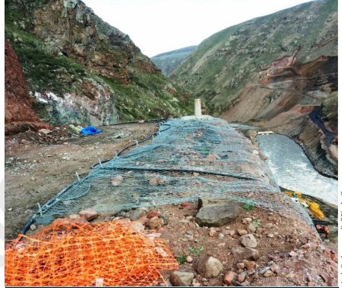
Resim 1. Ardahan Barajı Kazı Şevlerinde Koruma Uygulaması
