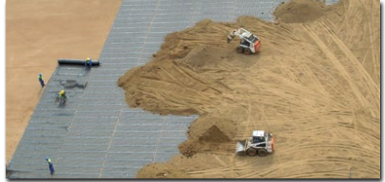
Obruk oluşumlarında temel zemini güçlendirme
